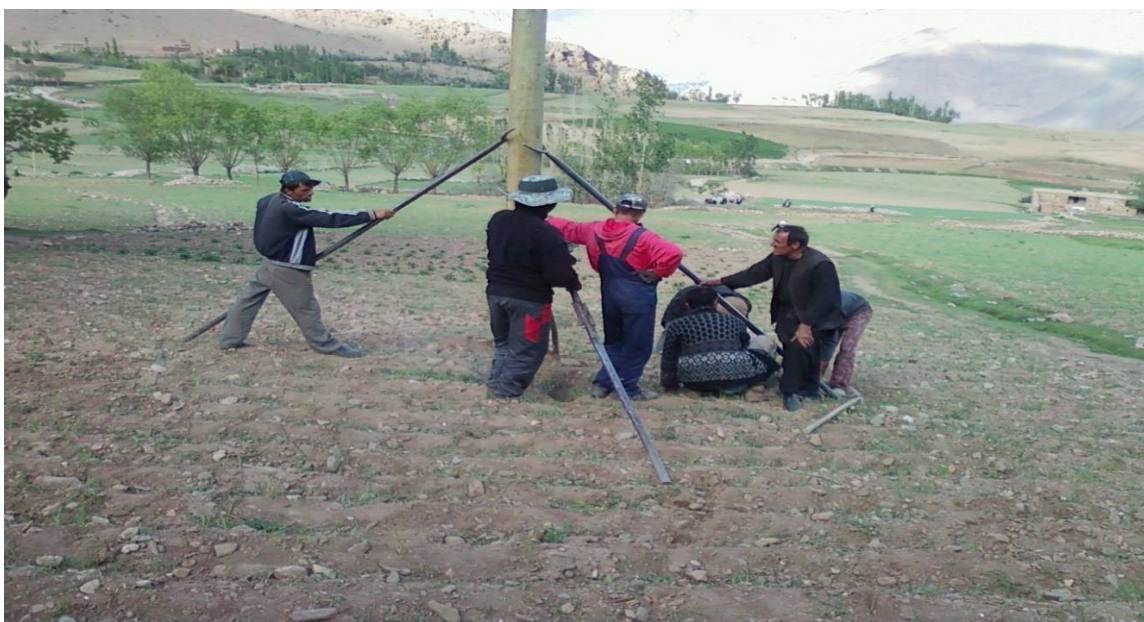
نصب کردن پایه برق در قریه ویر
